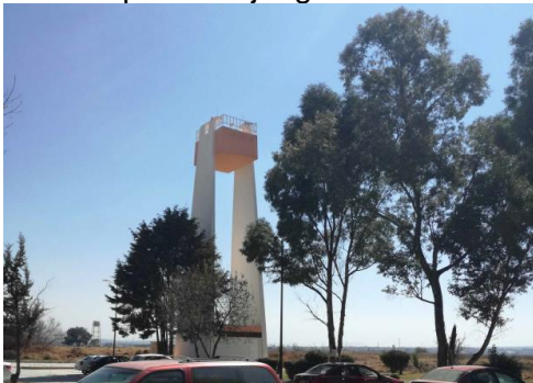
Tanque de agua elevado
